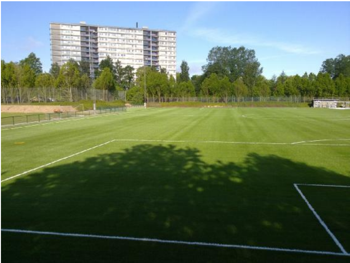
Virumgårdsvej – Lyngby-Taarbæk Kommune – ny full-size kunstgræsbane indviet juli 2010. Græsset er Greenfield 60 mm. med kvartssand og SBR-granulat. Banen er anlagt med "sne-depot" og opvarmningsareal.
