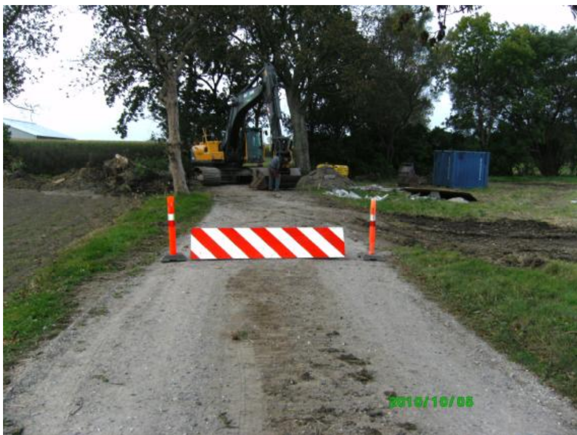
Hovvejen, Slagelse. Ny rørledning under vej i forbindelse med udvidelse af overkørsel. Arbejdet blev udført for Slagelse kommune.
