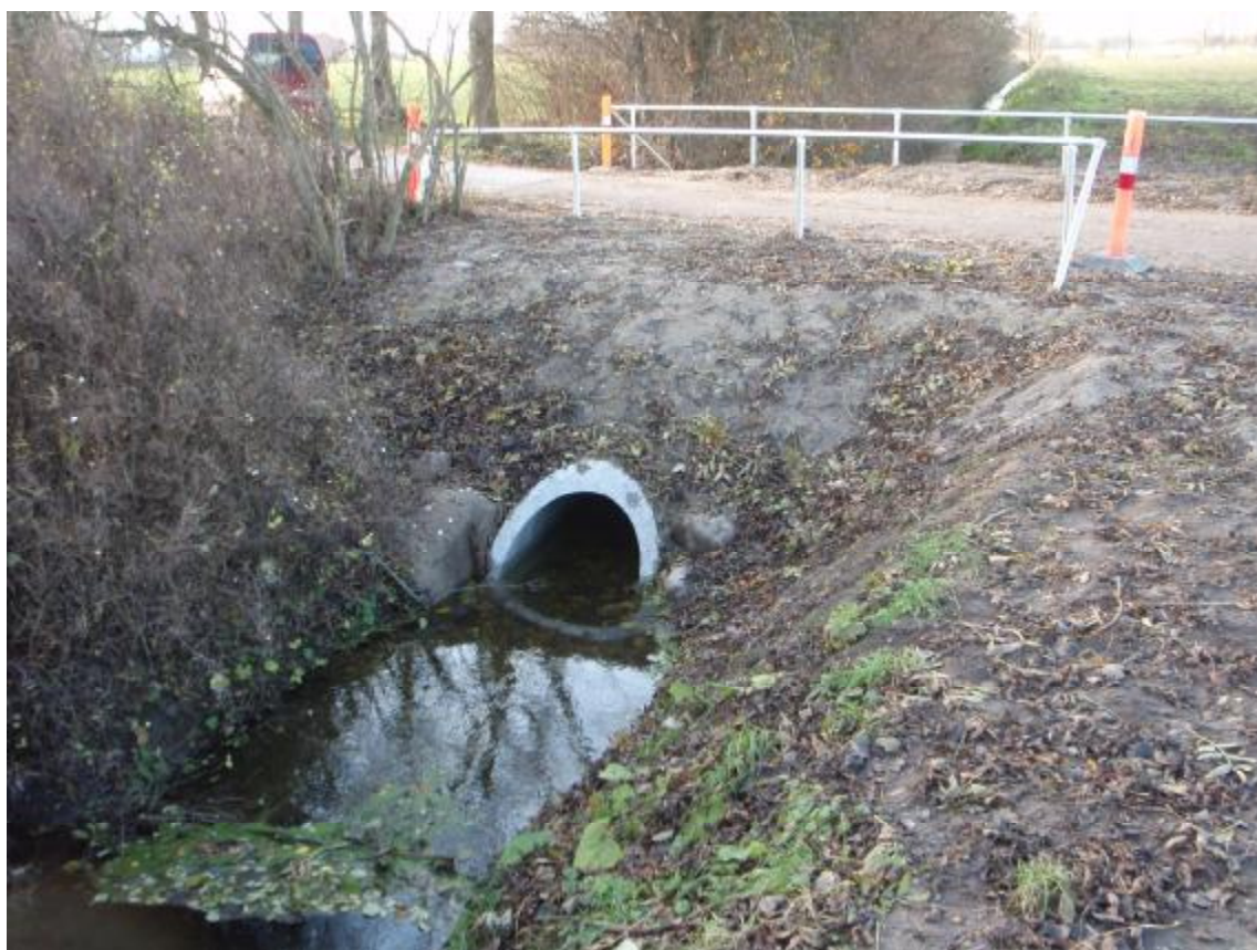
Hovvejen, Slagelse. Ny rørledning under vej i forbindelse med udvidelse af overkørsel. Arbejdet blev udført for Slagelse kommune.
