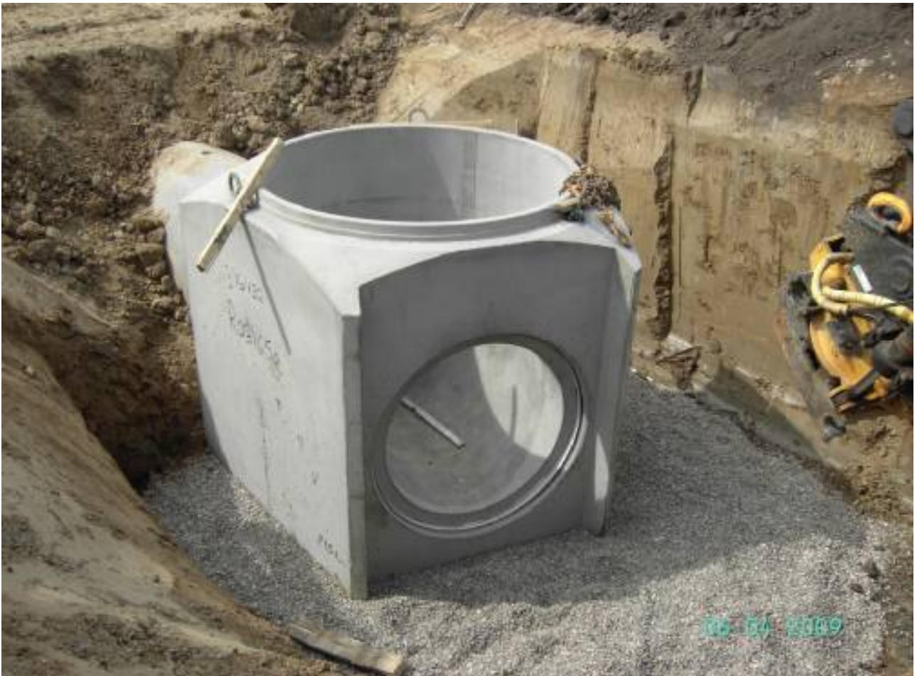
14,5 tons Ø1200 brøndbund er sat på plads.
