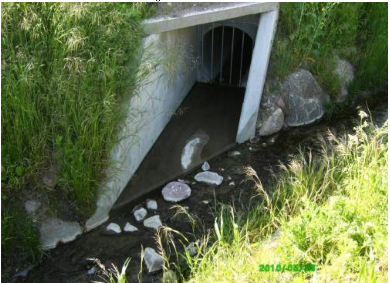
Selv et Ø1000 betonudløb kan integreres i naturen.
