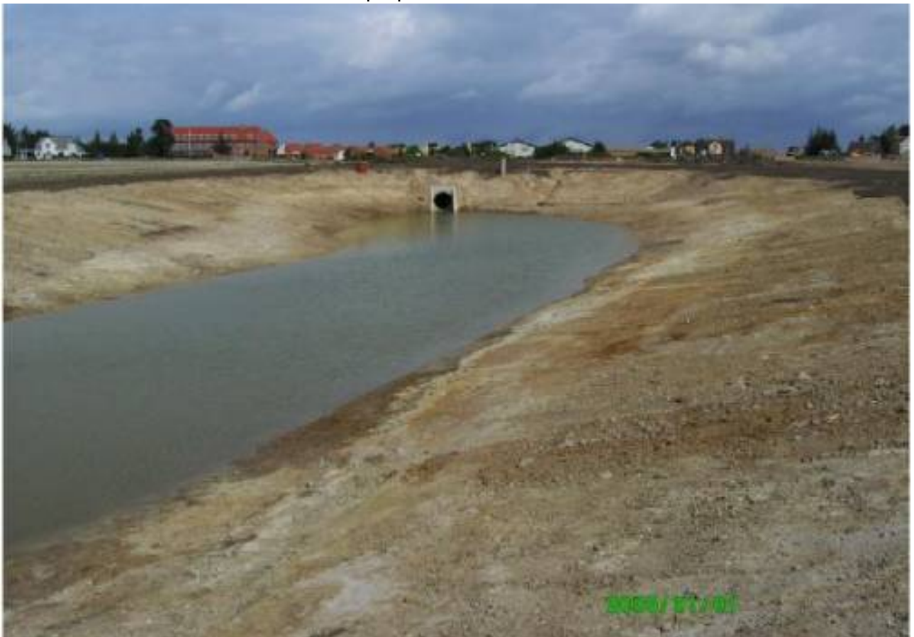
Bassinet er gravet ud. Bygværkerne er sat og systemet er i drift.
