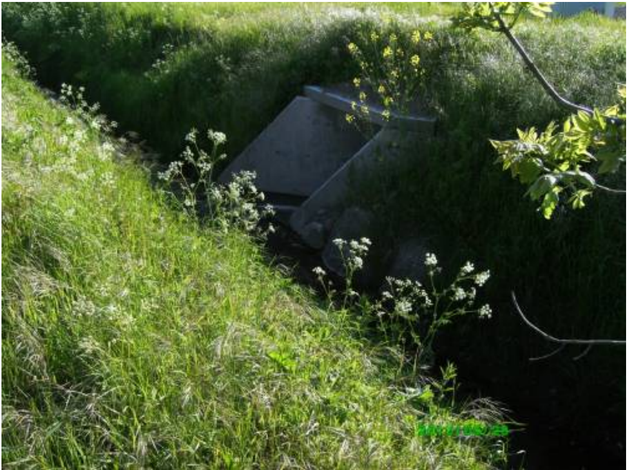
Selv et Ø1000 betonudløb kan integreres i naturen.
