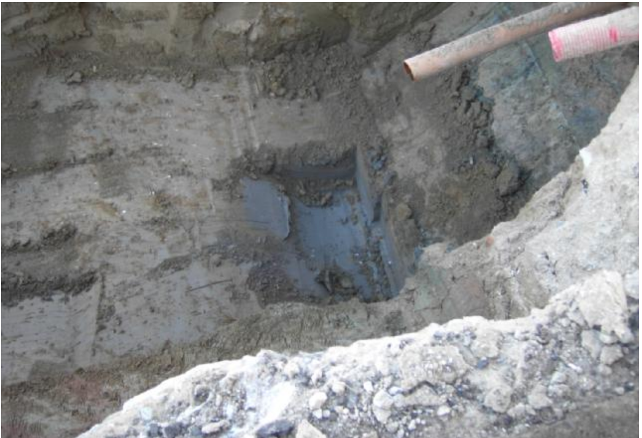
Udgravning synet af miljømanden og klar til installation af nyt udskillersystem. Pladsforholdene var snævre, men folkene fik det skruet godt sammen.
