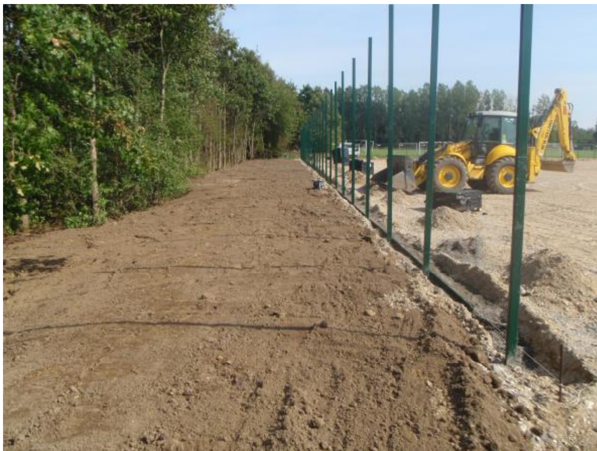
Gladsaxe Stadion - opbygning af bund for kunstgræsbane. Arbejdet er udført i fagentreprise og omfatter udgravning af muld, opbygning af bund, dræning, belægninger, opsætning af hegn m.v.
