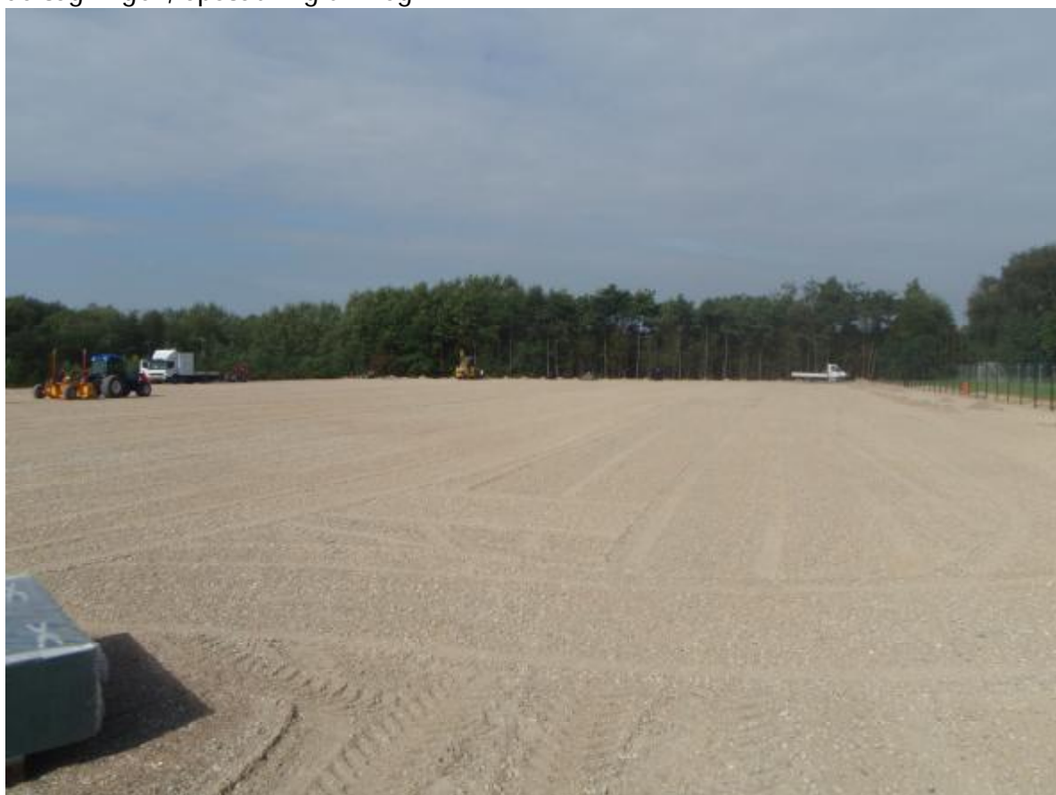
Gladsaxe Stadion - opbygning af bund for kunstgræsbane. Arbejdet er udført i fagentreprise og omfatter udgravning af muld, opbygning af bund, dræning, belægninger, opsætning af hegn m.v.
