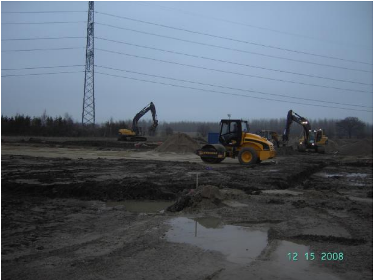
Skovbyen i Ringsted - byggemodning for 7 boligblokke med i alt 98 lejligheder. Arbejdet omfatter kloakering, belægninger, terrænarbejder m.v.
