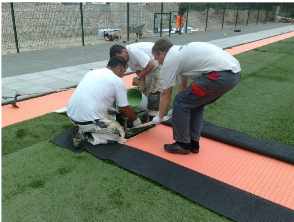
Mørdrup I drætsanlæg – etablering af kunstgræsbane udført i hovedentreprise. Arbejdet omfatter udgravning og opbygning af bund, dræning, belægninger og udlægning/limning af kunstgræs.
