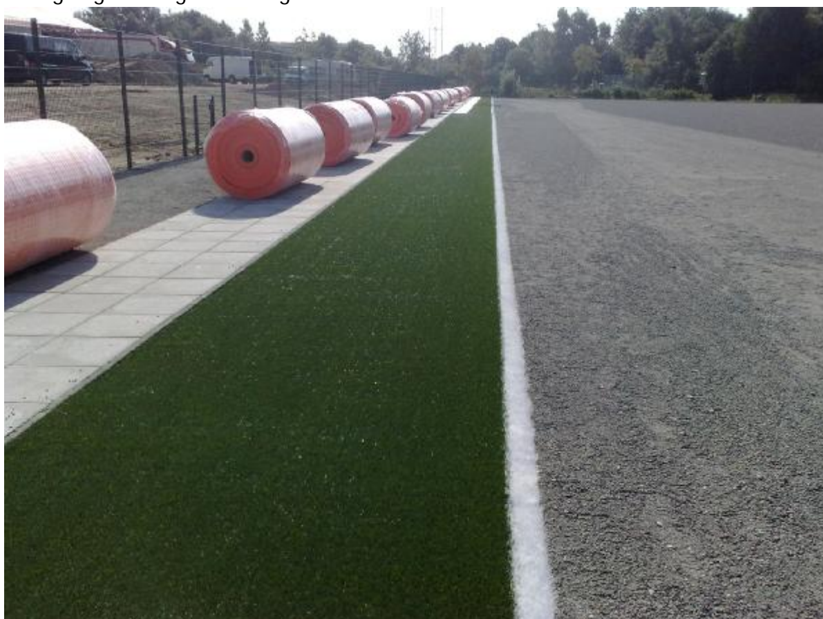
Mørdrup I drætsanlæg – etablering af kunstgræsbane udført i hovedentreprise. Arbejdet omfatter udgravning og opbygning af bund, dræning, belægninger og udlægning/limning af kunstgræs.
