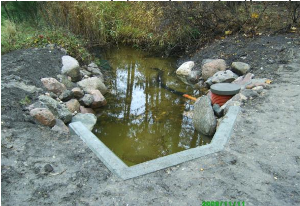
Oppumpningsbygværk mod Storebælt
