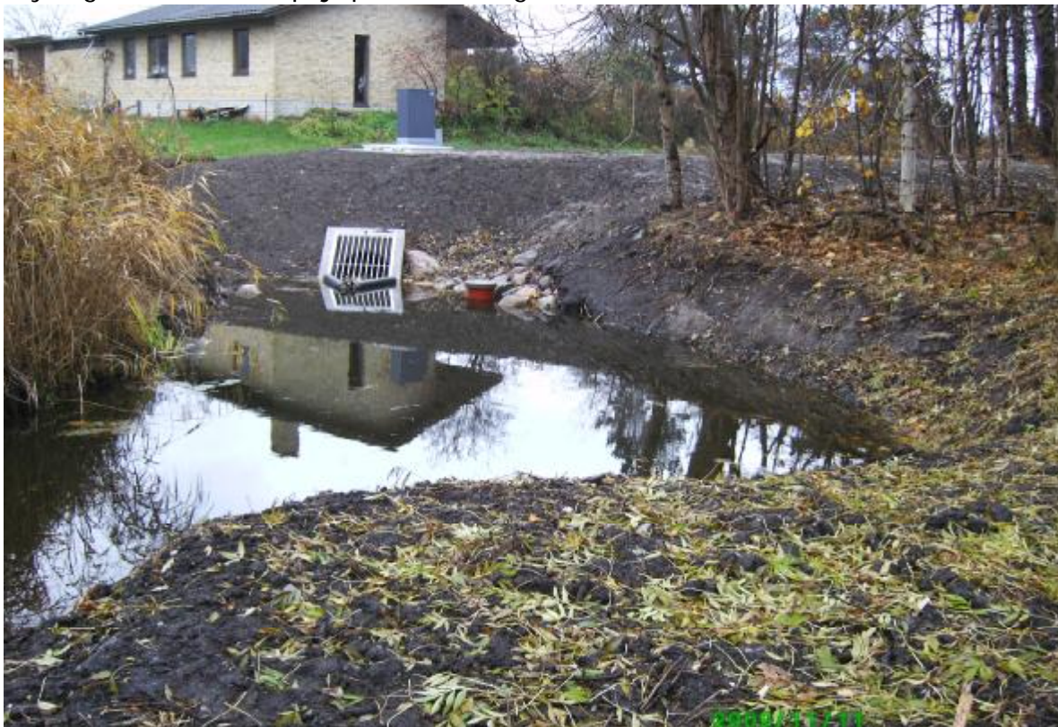
Pumpestationen med sandfang, styrebrønd og stensætning ved bygværker og ålepas.
