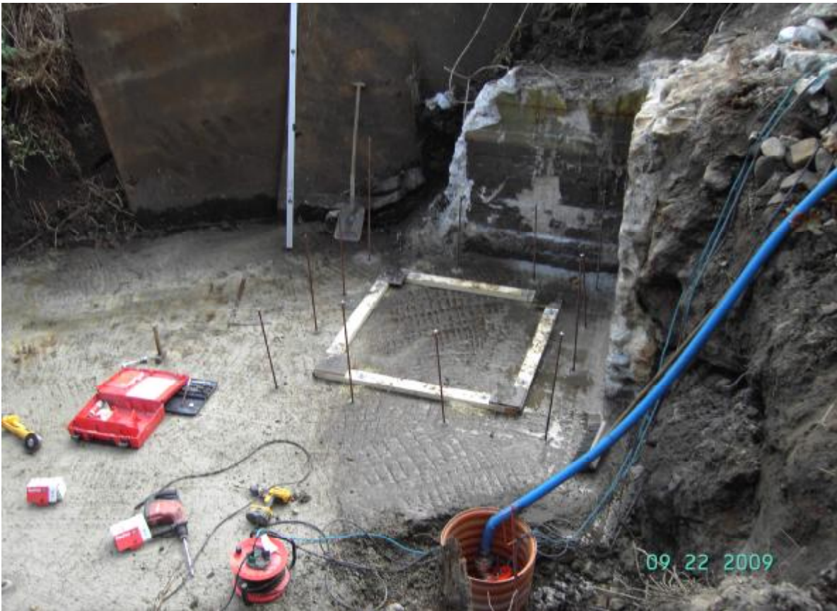
P.g.a. jordbundsforholdene, lod vi noget af det gamle bygværk stå som støbeforskalling. Renselaget blev ændret til en armeret betonplade under pumpestation og rør.
