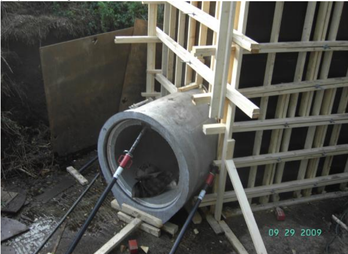
Et Ø1000 I G-rør blev skåret på gering og støbt sammen med pumpestation.
